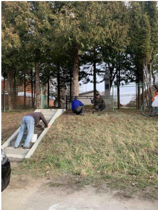
Проведено ремонт біля пам'ятника Лесю Гринюку
